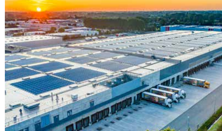
Distributiecentrum in Sint-Niklaas met 7.200 zonnepanelen op het dak.
